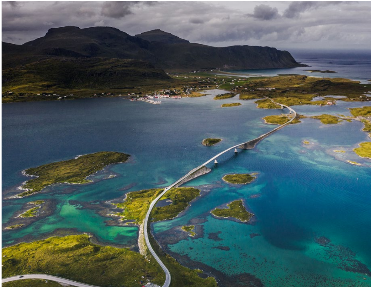
Von Insel zu Insel: Über Brücken und durch Tunnels gelangt man ohne Fähre bis zur äussersten Insel. From island to island: Over bridges and through tunnels you can reach the outermost island without a ferry.
